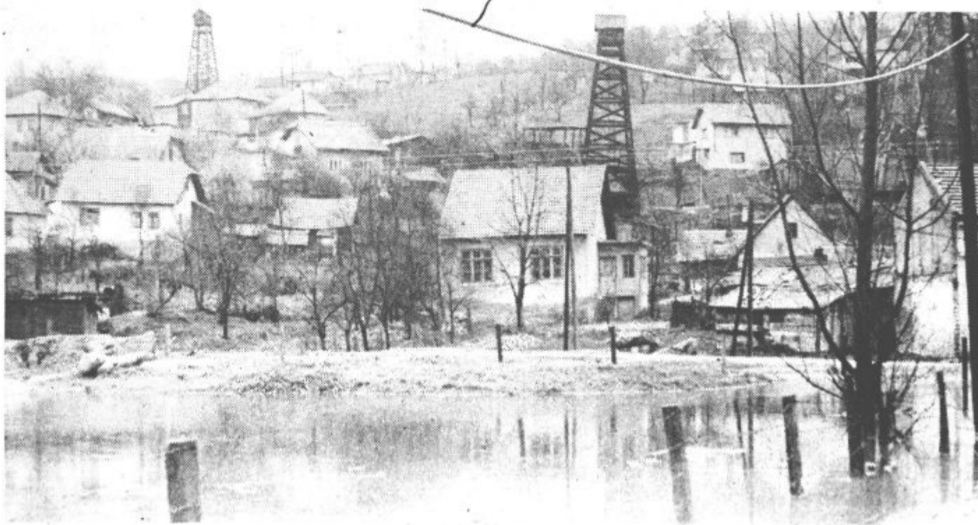
Ob mestnem obronku, tu je bilo pred leti središče Tuzle, so vodnjaki za črpanje slane vode, ki jo potem po ceveh dovajajo do solarne in tovarne sode. V ospredju je manjše jezerce, ki je nastalo zaradi ugrezanja
