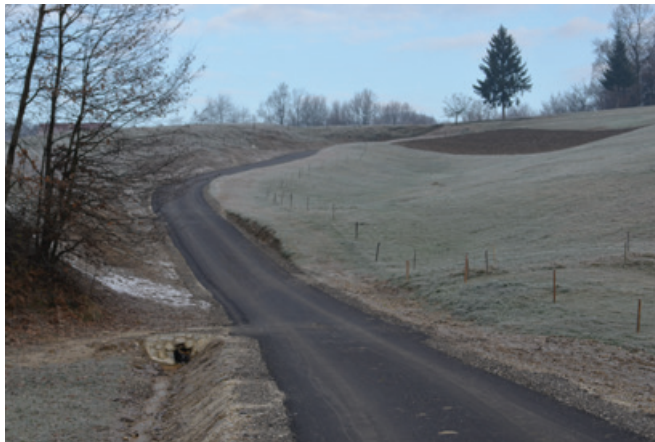
Modernizacija občinskih cest Krhiče-Kolar (foto arhiv občine).
