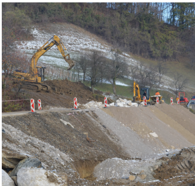
Sanacija plazu (foto arhiv občine).
