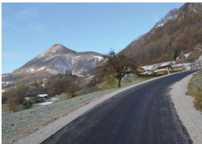
Modernizacija občinskih cest Rtiče-Selo (foto arhiv občine).
