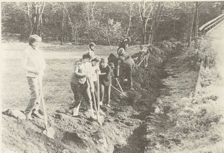
IZKOP OD GLAVNE CESTE DO MOSTU ČEZ SAVINJO
