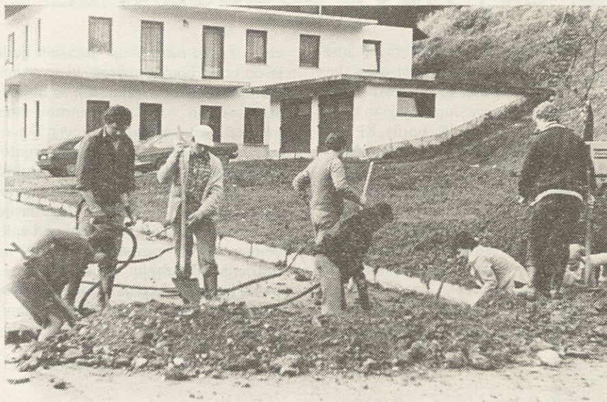
ZARADI PREKOPA CESTE JE BIL USTAVLJEN PROMET. PA NE ZA DOLGO
