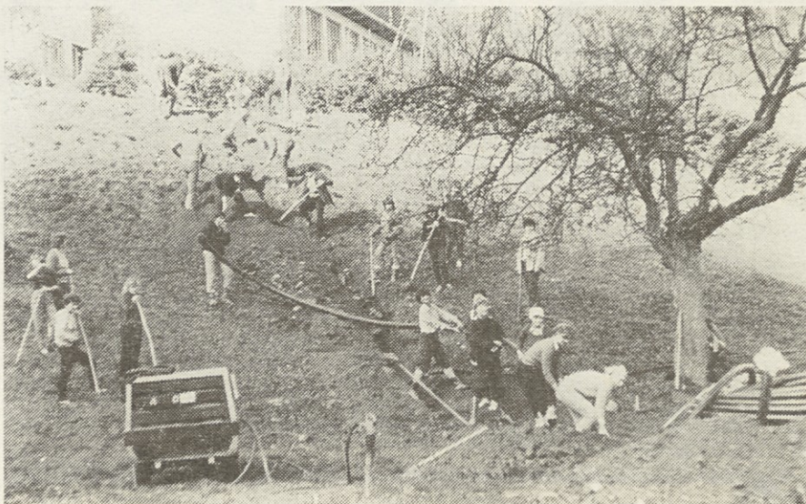
ŠE MALO IN CEV BO POLOŽENA IN ZASUTA
