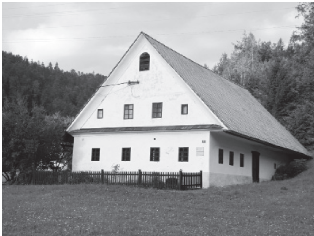
DEKD v Žireh, 2. 10. 2013. Matevžkova hiša v Novi vasi (zdaj Novovaška cesta, Žiri), kulturni spomenik, rojstna hiša slikarja Franja in arhitekta Vlasta Kopača, očeta in sina. / Foto: Rok Klemenčič
