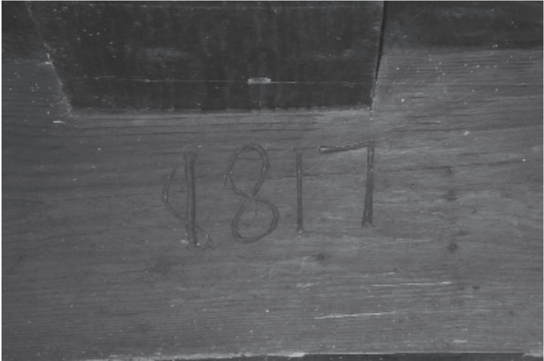
Slika 15. Letnica, vrezana v nosilni tram lesene stropne konstrukcije v nadstropnem prostoru, zgornji »hiši«. / Vir: Avtoričin osebni arhiv
