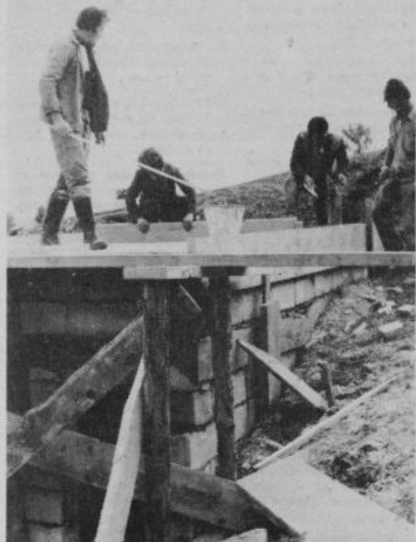
Krajanje Čretveža so ob občinskem prazniku pridobili vodovod - na sliki gradnja črpalnice
