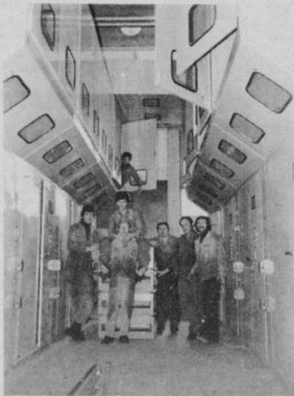
Za Irak so v Industriji stikalne opreme naredili 35 KV stikališče
