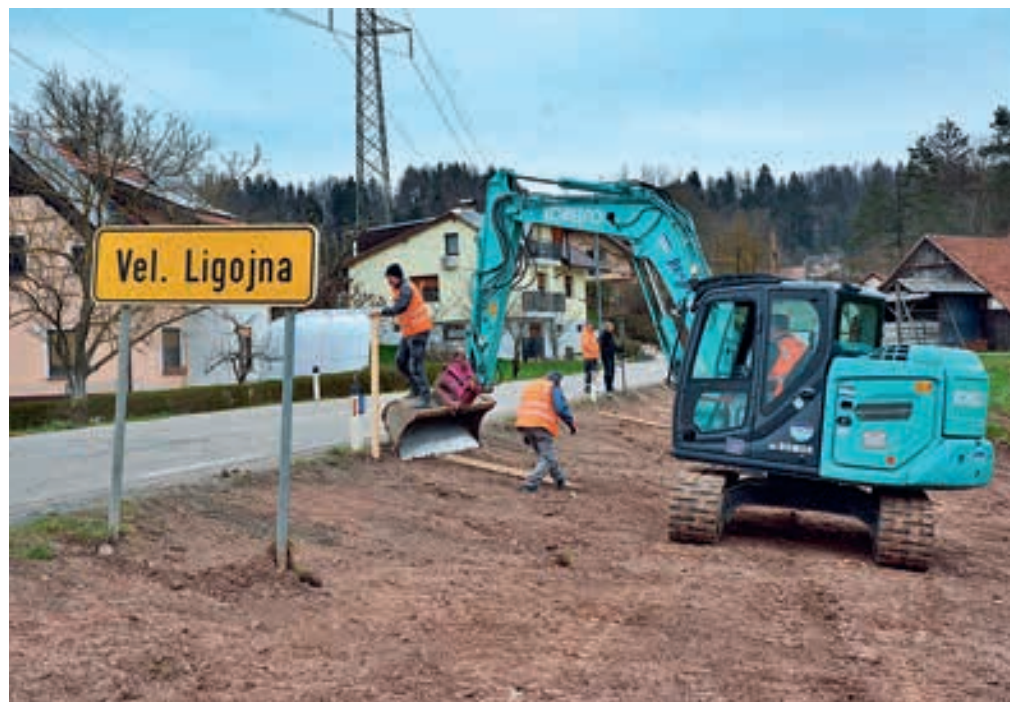
Začetek gradnje kolesarske povezave pri Veliki Ligojni
