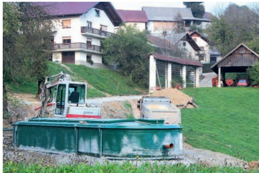
Z gradnjo kanalizacije in čistilne naprave v Žazarju se zaključuje obsežen projekt urejanja fekalnih voda v celotni občini.
