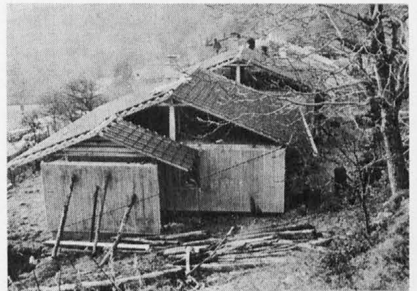
Naši ljudje niso obupali. Začeli so graditi nova stanovanja. Na sliki vidimo skupino montažnih hiš v gradnji, v Ceneboli, darilo S.R. Slovenije
