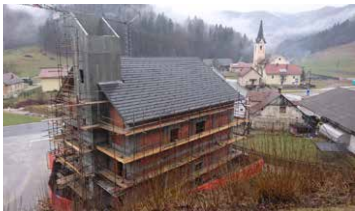
Gasilski center Blagovica po izvedeni strehi v januarju 2019.
