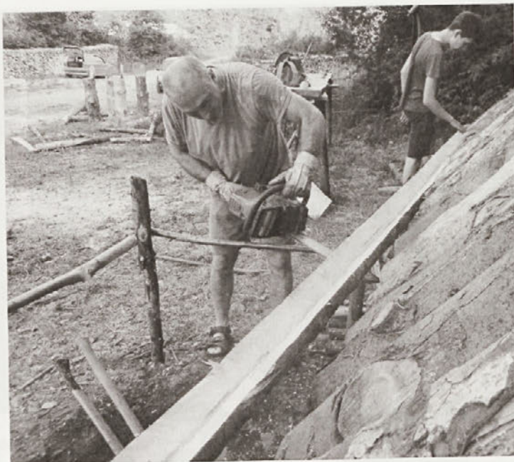
Janez pri obdelavi žleba. »Kakšna je oglarska bajta brez žleba?« je bilo njegovo vprašanje, ko smo ostali podvomili v smiselnost njegovega početja. Foto: F. Trošt
