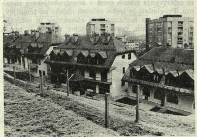
Slika 1. Pogled na novozgrajeno (v sredini) in revitalizirani stari zgradbi na Lončarski stezi v Ljubljani
