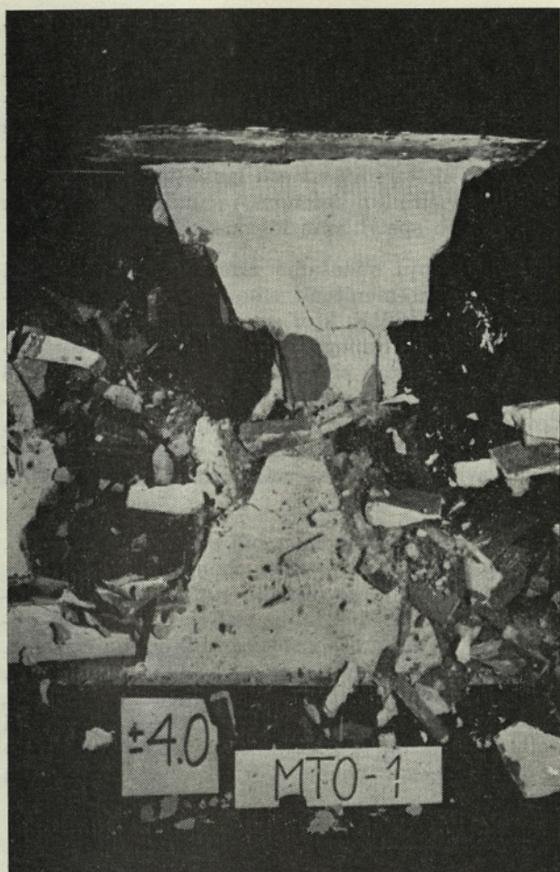
Slika 1. Nearmirani zid v trenutku strižne porušitve
