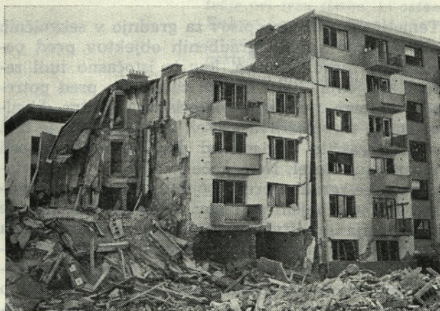
Slika 1. Skopje 1963. Porušitev pritličja
