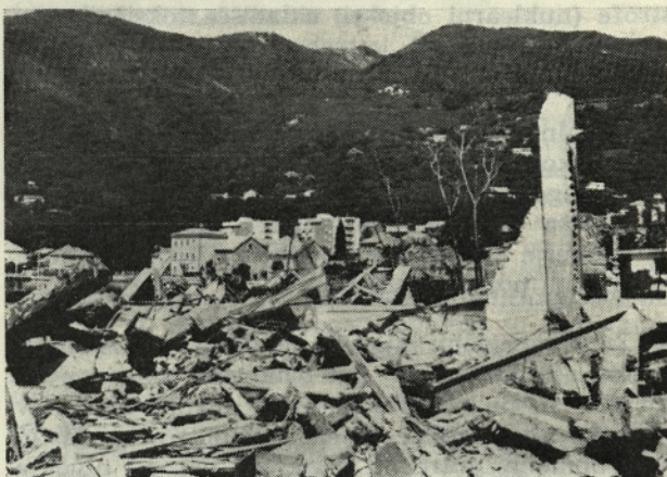
Slika 8. Črna gora, Bijela 1979. Porušitev ladjedelnjskih zgradb
