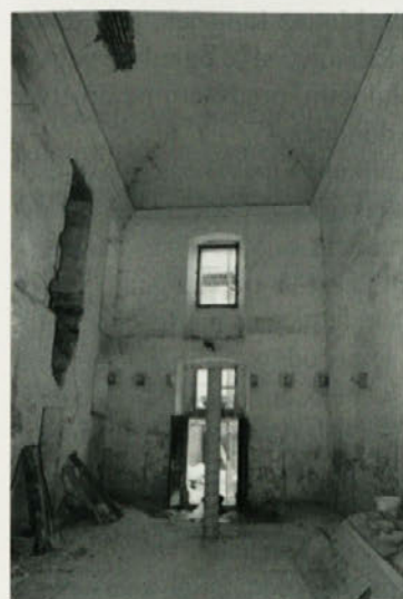
Grajska kapela pred obnovo, v sredini nov steber
