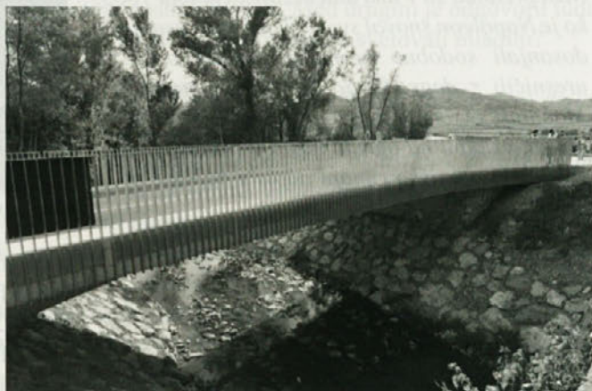
Pogled na novi most čez Močilnik
