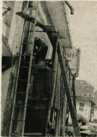
RADOVLJICA — V Radovljici predvidevajo, da bodo postopoma obnovili notranjost, predvsem pa pročelja več sto let starih poslopij na Linhartovem trgu, ki se nahaja v starem delu mesta. Pred kratkim so obnovili Sivčevo hišo, zdaj pa obnavljajo njeno pročelje. — B. B.
