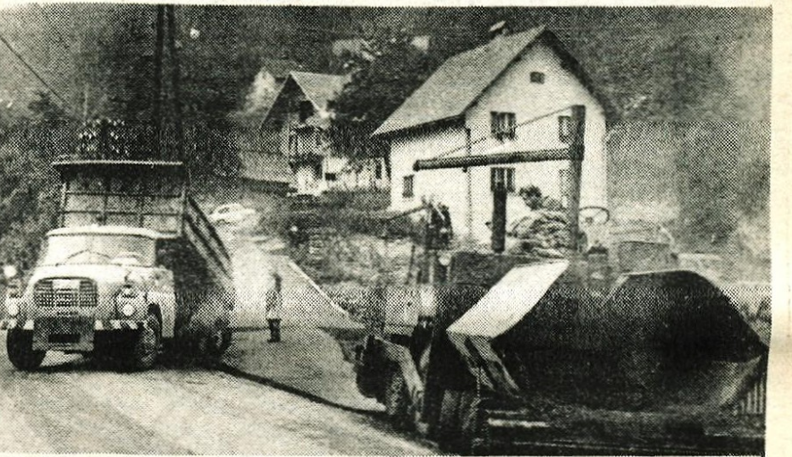
Asfalt na krajevnih cestah Bohinjske Bele - Po domala vseh krajevnih cestah in poteh na Bohinjski Beli so delavci Cestnega podjetja iz Kranja minule dni položili asfalt, tako, da so danes ceste in poti asfaltirane. Tako je krajevna skupnost Bohinjska Bela uresničila dolgoletno željo krajanov, da dobijo tudi na Bohinjski Beli asfalt. Položili so ga na 12.000 kvadratnih metrih površine. - Foto: F. Perdan
