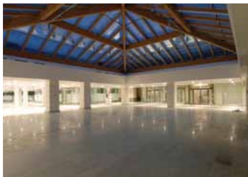
Notranjost postaje Trieste Centrale.
