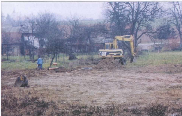
GRADNJA KANALIZACIJE A SZENYVÍZCSATORNA ÉPÍTÉSE
