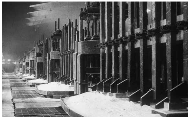
Peči s predpečeno anodo v hali B
