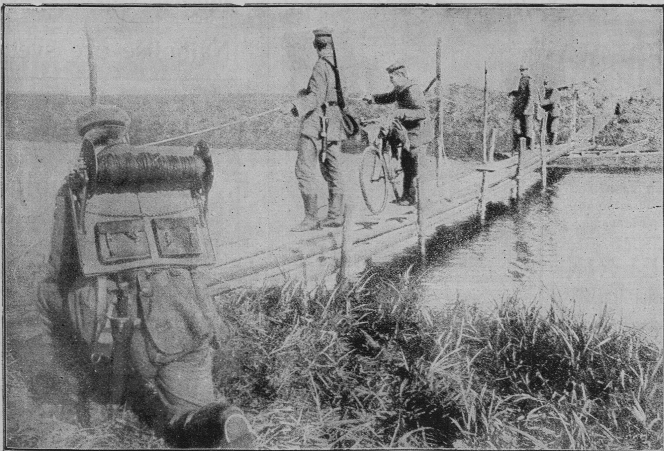
Polaganje telefonske žice na bojišču v Nieuportu.
