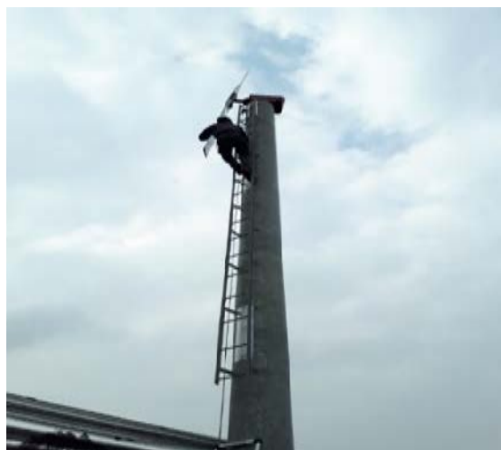
Bild 5: Montage der Windmaschine des Typs Orchard Rite. Autor: Steinbauer L.
