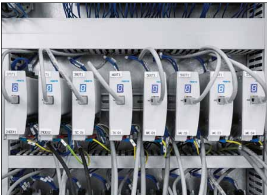
Slika 4. Krmilniki CMMO-ST v krmilni omari omogočajo preprosto namestitvev ter hitro pripravo in zagon pogonskih paketov (foto: Festo AG &Co. KG).
