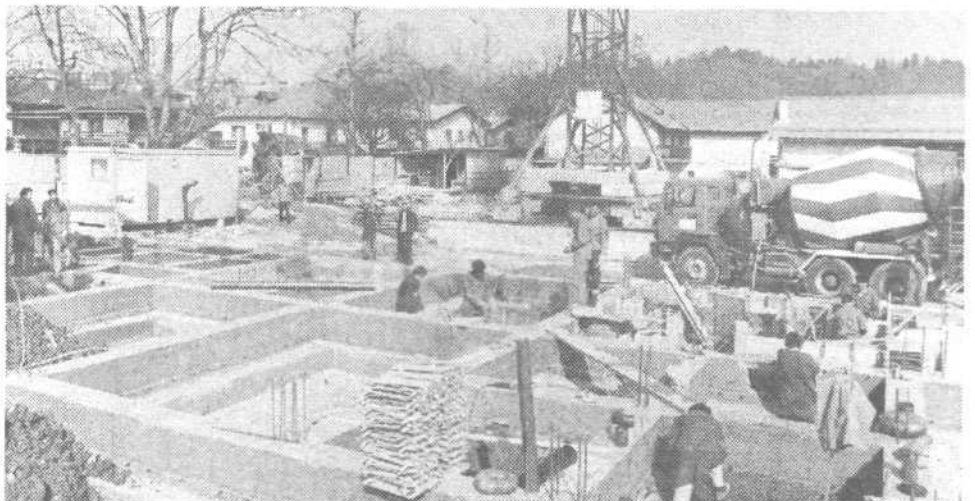
Ob Opekarjevi cesti, na kolaciji nekdanjega KIP-a raste nov objekt. Marsikdo se sprašuje, kaj neki bo to. Izolski Galeb, to je naša prva informacija, gradi poslovno-stanovanjski objekt, ki naj bi streho dobil še v tem letu.
