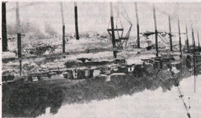
Gradbišče »Emo« v Senta pri Celju na dan poplave 9. 10. 80
