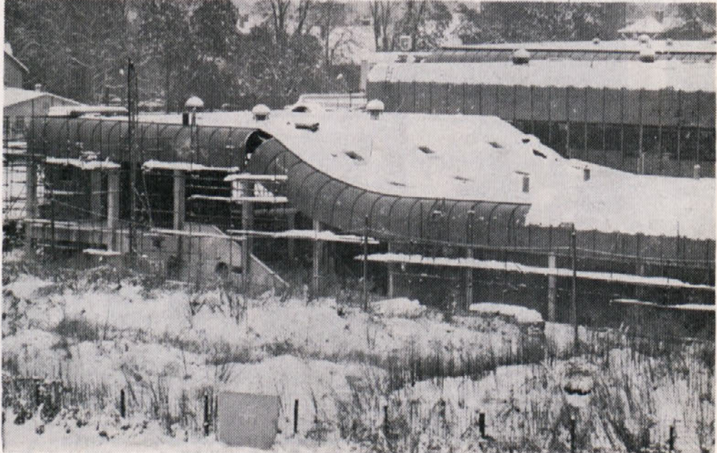
Letošnji jesenski sneg je presenetil vse, nam gradbincem pa zavrl ali otežkočil delo. Posnetek je z gradbišča »Kegljišče in pokriti bazen Golovec« v Celju 3. novembra 1980
