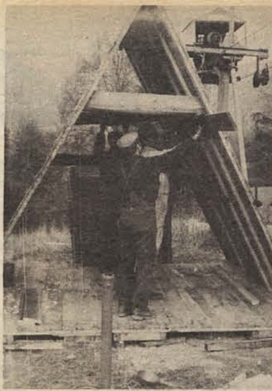
V soboto, 21. oktobra, je 18 članov smučarskega kluba „Rog“ iz Novega mesta v prostovoljni delovni akciji obnavljalo smučarsko vlečnico. Na novo so prebarvali nosilce vlečnice in zgradili novo komandno hišico.
