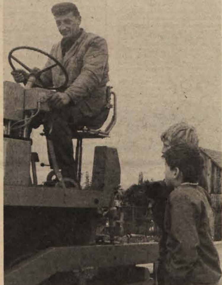
V Črešnjicah pri Cerkljah si radovedni fantiči z zanimanjem ogledujejo novi finišer - stroj za polaganje vseh vrst asfalta do treh metrov širine. Kupil ga je cestni sklad pri občinski skupščini v Brežicah za modernizacijo občinskih in krajevnih cest. Zanj je odšteli 870 tisočakov. Asfaltirano cesto Cerklje - Črešnjice - Hrašnje so slovesno odprli v četrtek, 25. oktobra. (Foto: Jožica Teppey)
