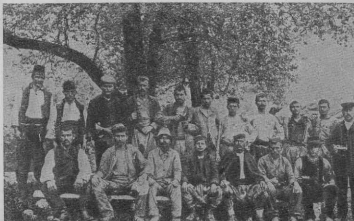
Sl. 2. Makedonski delavci pri gradnji železnice Celovec-Trst
