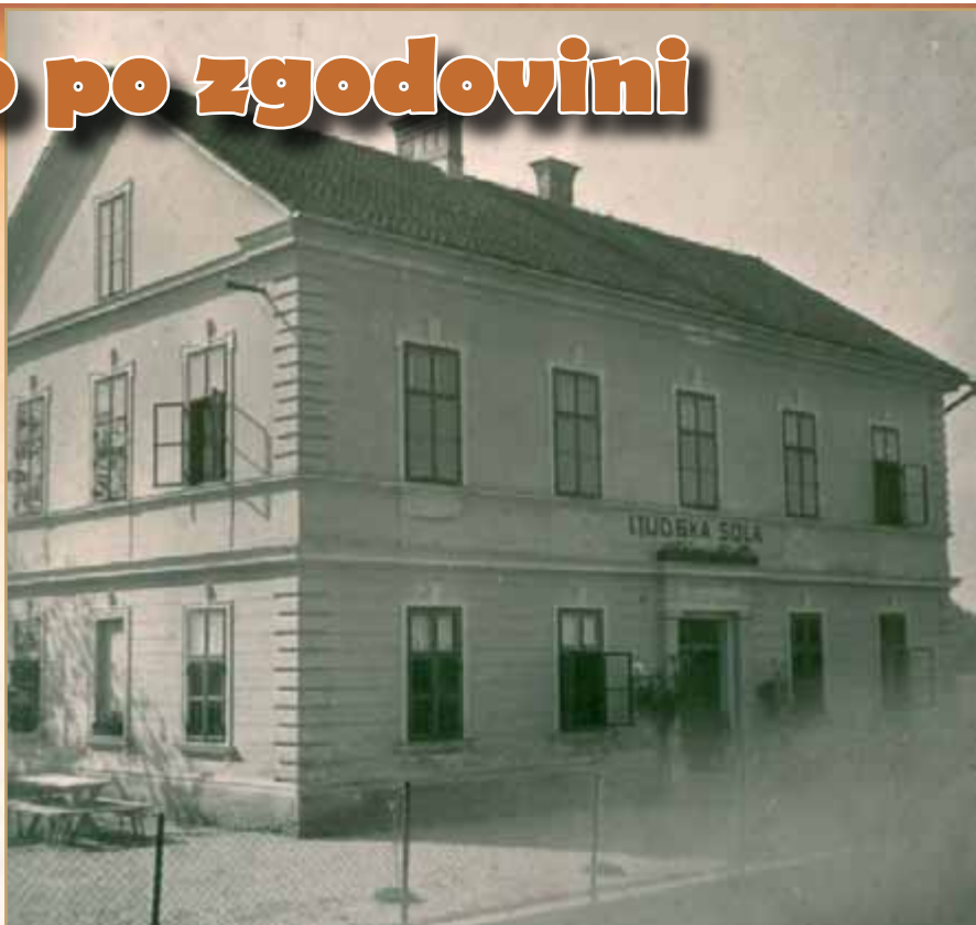
Osnovnošolska stavba v Vodichah okrog leta 1930. (Slovenski šolski muzej, fototeka, inv. št. 846).
