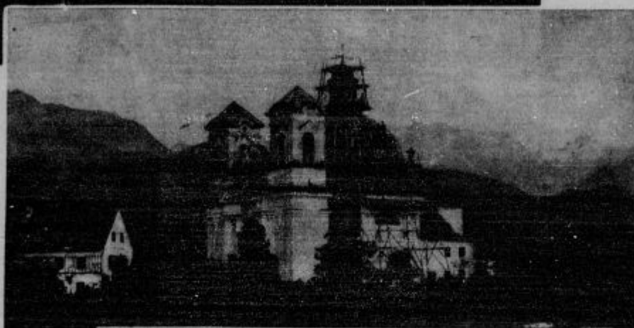
Tunjška farna cerkev (pri Kamniku) je deloma pogorela. Vneli župljani pa so se takoj lotili dela, da cerkvi vrnejo prejšnjo lepoto. — Slika nam kaže graditev ogrodja za kupolo. Pozneje pride na vrsto tudi oba lepa zvonika.
