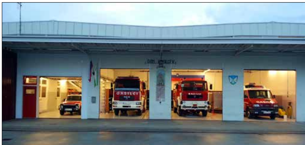
Danes je to moderen gasilski dom s klicnim centrom, vendar glede na potrebe že premajhen. Vir: PGD Železniki.
