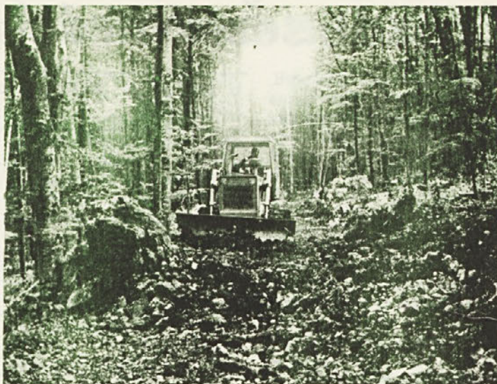
Letos so delavci TOZD Gozdarstvo Novo mest razširili kamionsko cesto „Drenšajba“, odd. 20 v Radohi. Cesta je dolga 800 m. Zemeljska dela je opravil buldožerist TOZD Transport in gradnje. (Foto M. Bajt).
