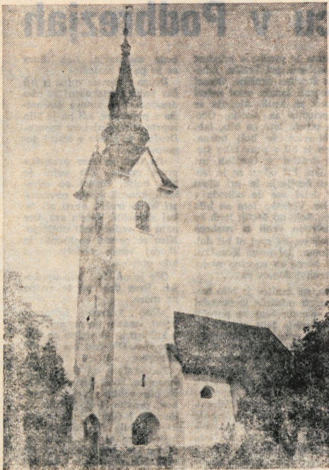
Spodnjebesniška cerkev iz leta 1456 (v preteklem poletju so bila v njej opravljena spomeniško-varstvena in obnovitvena dela). — Foto: F. Perdan
