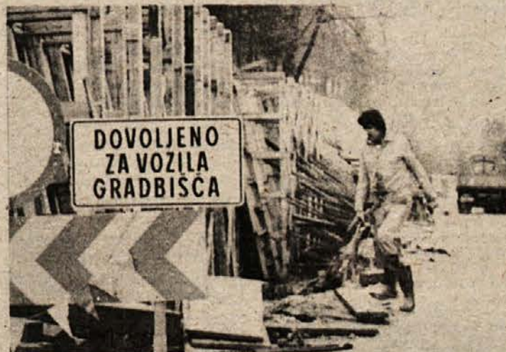
DELAJO V PETEK IN SVETEK — Te dni betonirajo ogromno skarpo na Cesti herojev, tik za cestno zaporo. Gradbišče je tu odprto vse dneve, tudi ob sobotah, do poznih večernih ur. Pionirjevci hite, da bi izpolnili obljubo: predati cesto prometu do 25. decembra. (Foto: Bačer)
