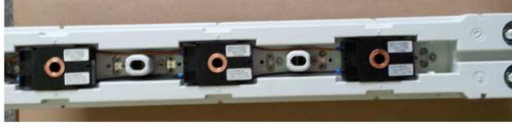
Vgradnja toroidnih transformatorjev v stikalno leto
