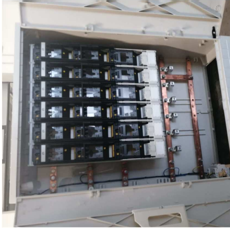
NV-varovalčno stikalna letev za zbiralni sistem 3 polna
