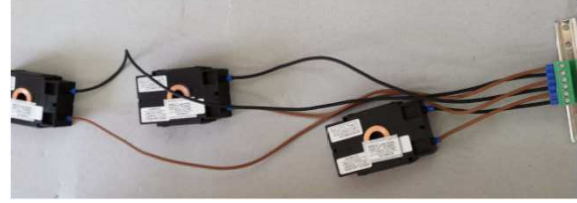
Vgradnja toroidnih transformatorjev v stikalno leto
