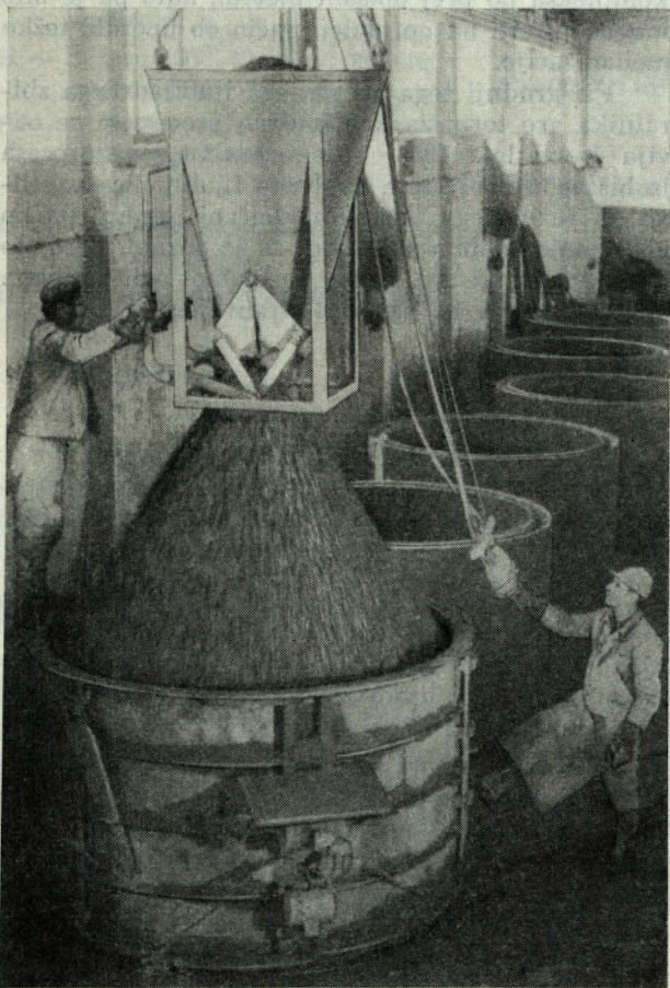
Sl. 1. Proizvodnja cevni elementov iz odcejanega betona. Na sliki je vidno vspanje betona med aktivni zunanji in notranji opaž. Na opažu so nameščeni opažni vibratorji. V ozadju so vidne pravkar izgotovljene cevi. — Metodo je razvil ZRMK
