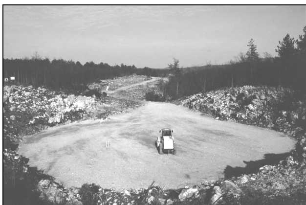
Sl. 2: Zapolnjevanje vrtače z gruščem. Iz vrtače so najprej odstranili naplavine. Danes je pod avtocesto med Kozino in Divačo.
