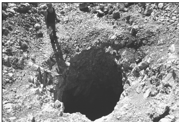
Sl. 7: Udor stropa jame med graditvijo useka pri počivališču pri Divači.
