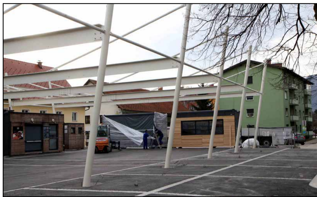
Gradbena dela z zunanjo ureditvijo tržnice so končana, konstrukcija nadkritja že stoji.
