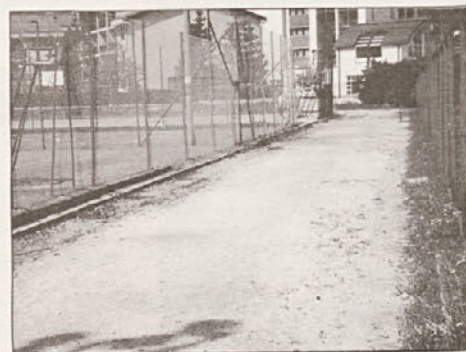
Takole si je izvajalec del predstavljal dokončno sanacijo atletske steze.
