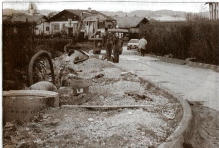
Gradbišče ceste do grosupeljskega pokopališča.
