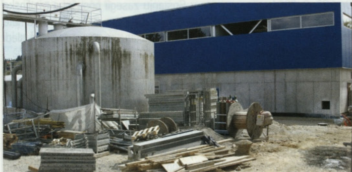
Gradnja osrednjega čistilnega objekta za pitno vodo Šaleške doline na Grmovem vrhu napreduje po načrtih. Foto: Jože Miklavc
