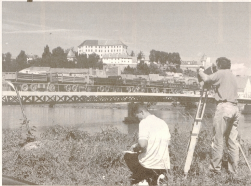
Slika za zgodovino: tovornjaki so na novem ptujskem mostu za pešce le za preizkus meritve nosilnosti, pri čemer so merili deformacije. Foto: Kosl
