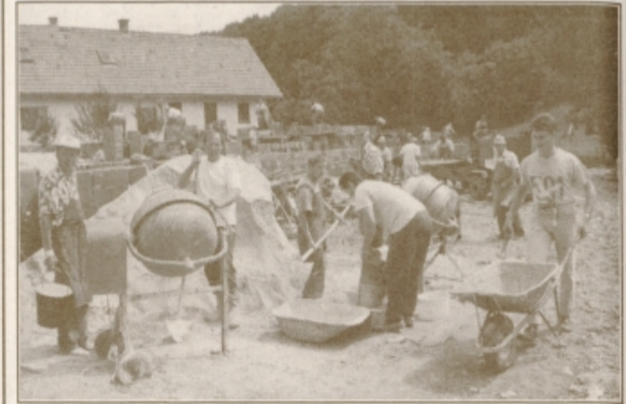
V soboto je bila prava delovna akcija. Na gradbišču se je zbralo okrog 50 prostovoljcev, ki so porabili okrog 5000 opek.
