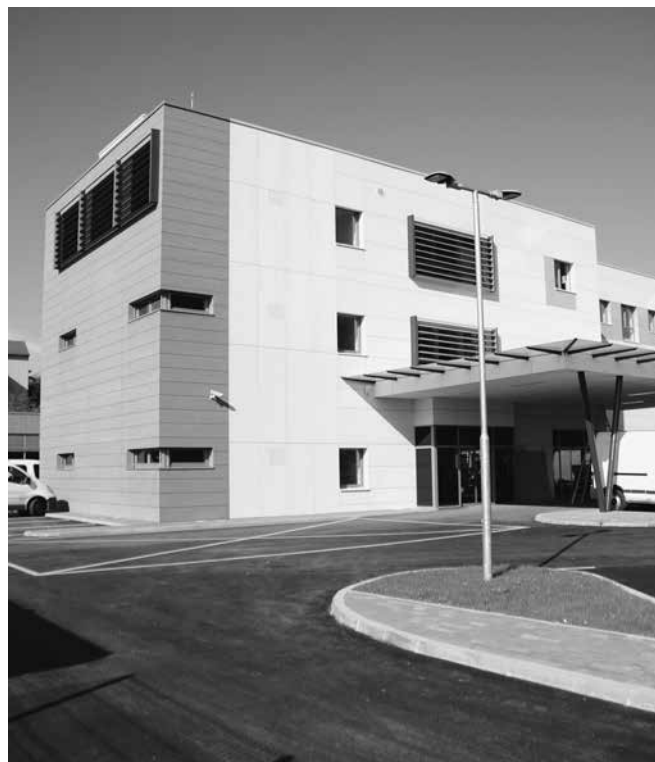
Objekt onkologije in radioterapije v UKC Maribor je zgrajen.
