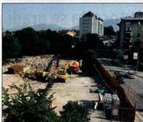
Začela se je gradnja garažne hiše z 250 parkirnimi mesti, ki bo zgrajena že letos.
