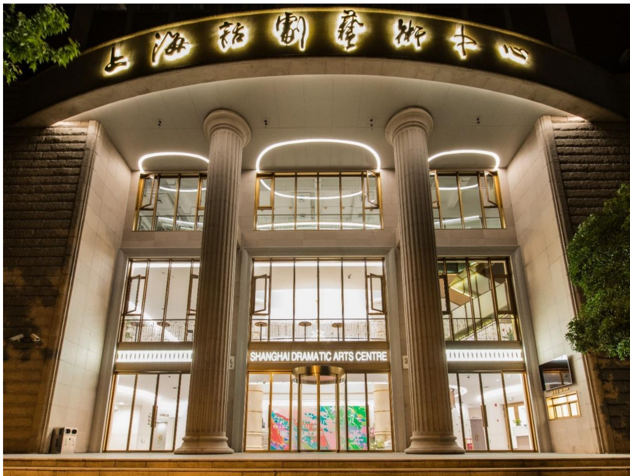
Slika št. 1. Šanghajski center dramskih umetnosti na Anfu Road, Šanghaj. Last Šanghajskega centra dramskih umetnosti.
