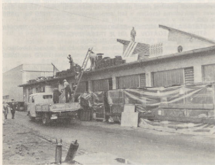
TOZD Kovinska obdelava je že pod novo streho
