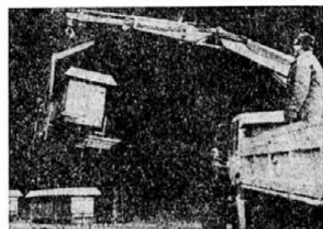
(Slika 8) Stojala s petimi panji se zelo hitro in naenkrat dvignejo na kamion s hidravličnim ali električnim dvigalom. To je nujno pri večjih čebelarstvih
