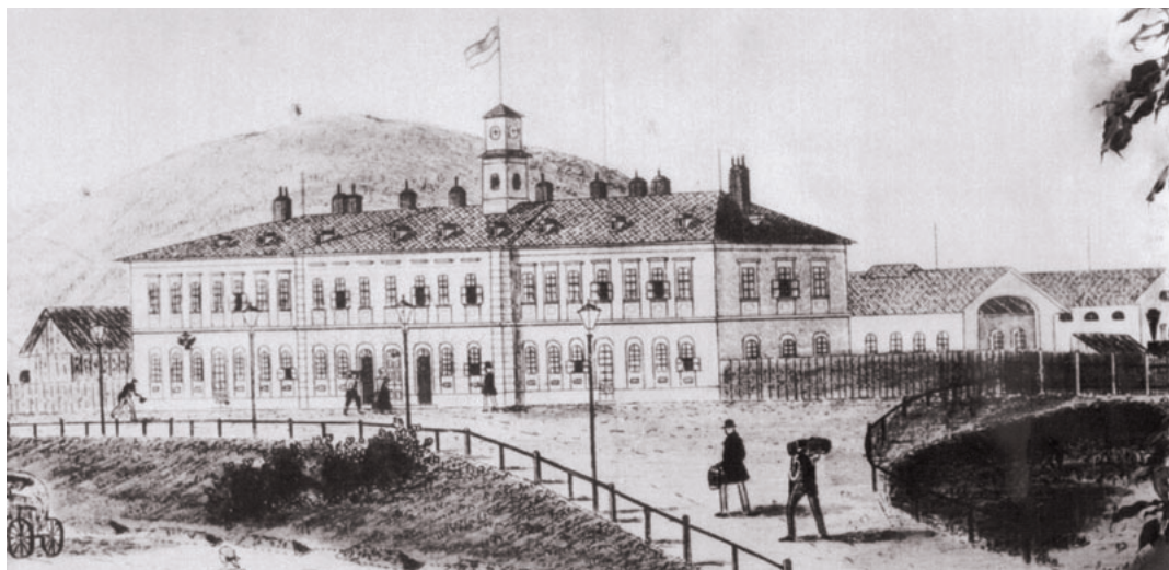
Mariborski kolodvor, ko so leta 1846 odprli del Južne železnice od Gradca do Celja.
