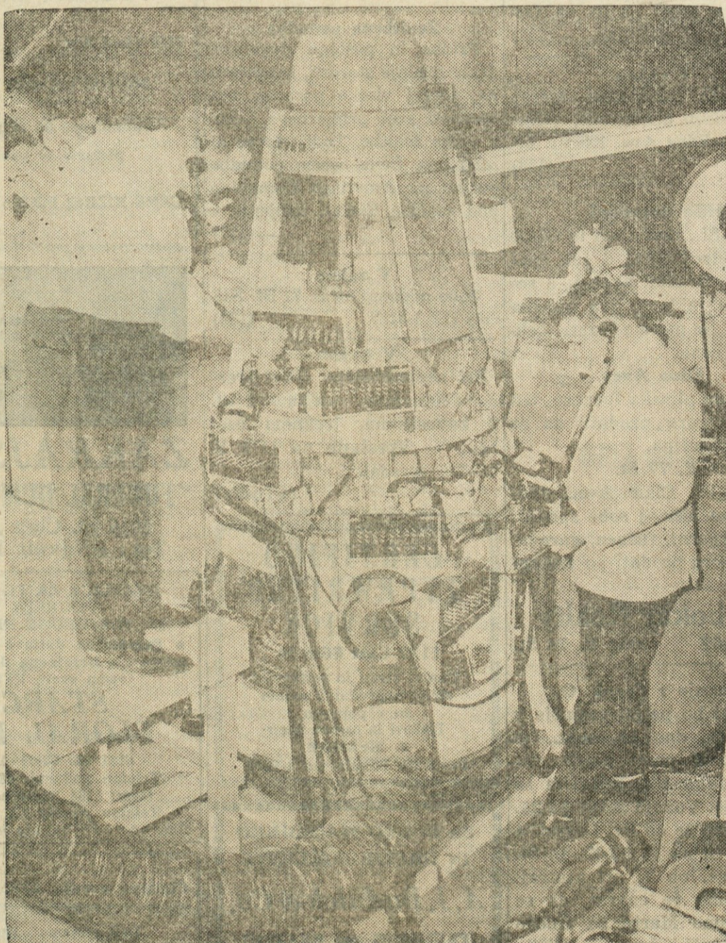
NAMENJEN V VESOLJE — Stožčasti stolpič, na katerega je pritrjena vrsta aparatov, je vesoljsko poskusno vozilo, ki naj pomaga pri izpopolnitvi krmarjenja vesoljskih vozil v pomočjo zvezd. Sestavljajo ga v Little Falls, N.J.
