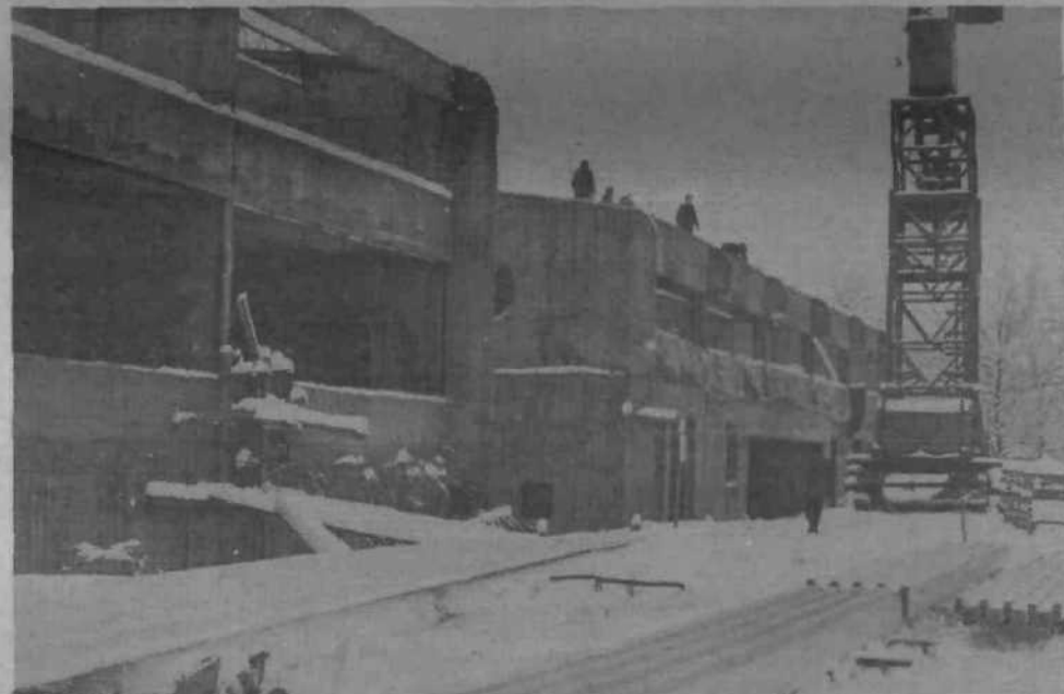
Še ne do kraja zgrajeno novo črnuško šolo je prekril sneg. To pa ne bo ovira, da ne bi bila šola zgrajena do zagotovljenega roka. Na nedavni seji gradbenega odbora je bilo slišati, da je terminski načrt za storitve realen in da bodo vsa dela opravljena v določenih rokih. Tako bo s šolskim letom 1978-79, ko se bodo odprla vrata nove šole, končno rešen pereč problem šolanja črnuških otrok.
