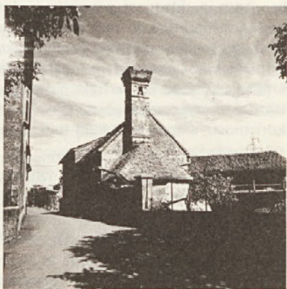
„spahnjenca“ – prizidano ognjišče z dimnikom (Kras);
