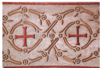
Sgrafitto tehnika na stropu meniške krstilnice.
