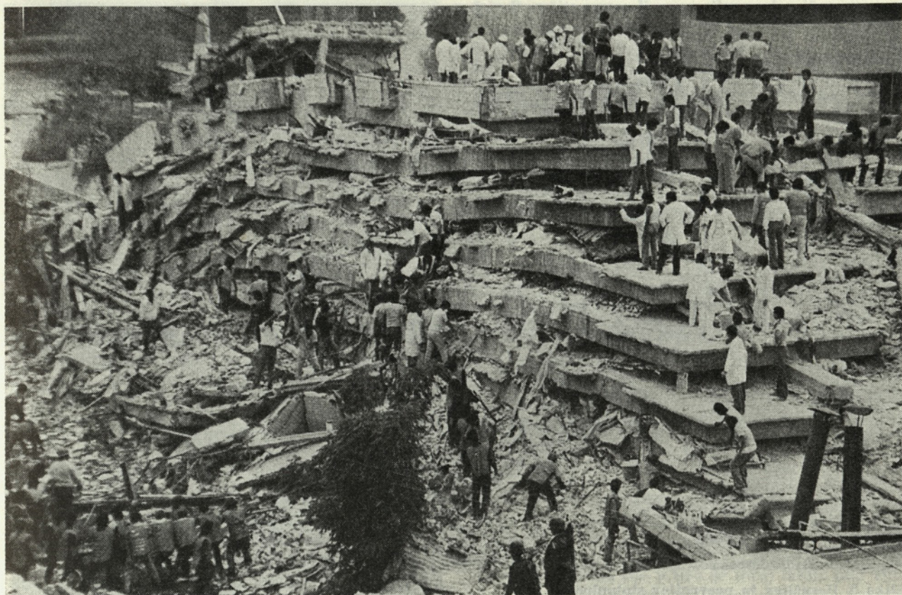
Slika 4. Porušitev stavbe zaradi rušenja vertikalnih nosilnih elementov konstrukcije
