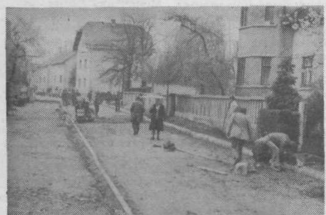
Končno so se le lotili asfaltiranja zadnjih metrov makadama v Zvezni ulici, kar je bila dolgoletna želja občanov pa tudi krajevne skupnosti Zelena jama. Zahvala gre predvsem občinski skupščini ter delovnim organizacijam občine, ki so finančno podprle to akcijo. Besedilo in slika EDI
