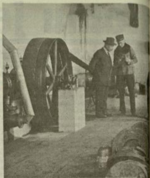
Mehanična delavnica v nekdanji Westnovi tovarni.
